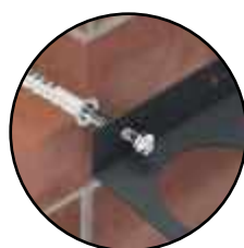
FISSAGGIO SU MURO
